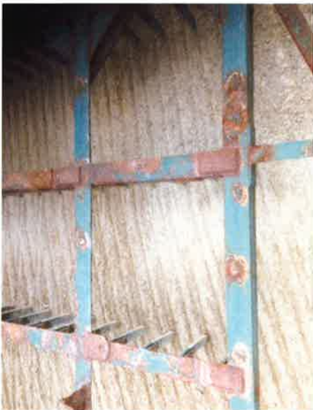
○フレーム拡大 腐食著しい
