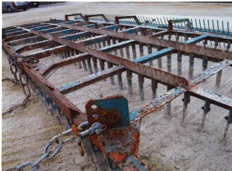
○フレーム拡大 腐食著しい
