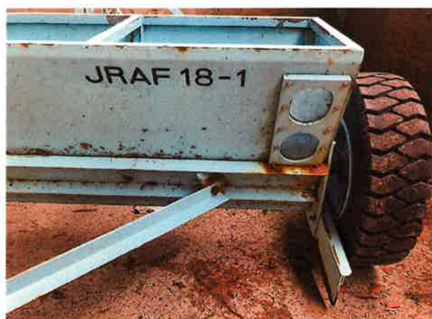
○右タイヤ周辺 腐食状況
