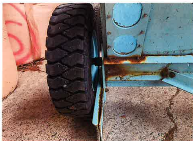
○左タイヤ周辺 腐食状況
